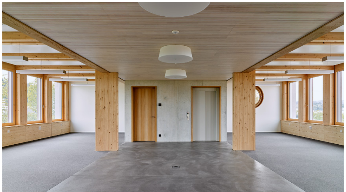
Die Unterzüge liegen nicht am Beton auf: Im Bürohaus ist das Holztragwerk konsequent an den aussteifenden Betonkernen vorbeigeführt.
