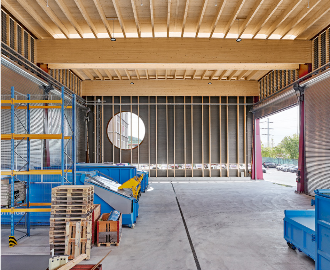
Das Rundfenster in den Stirnseiten der stützenfreien Halle lässt an eine Kathedrale denken: Ist Recycling die neue Religion?
